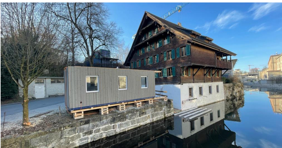
KreativRaum, Obermühlestrasse 22, 6330 Cham
